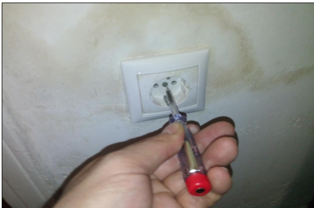
Βήμα 3 ο : Αποσυναρμολογούμε με το κατσαβίδι το περίβλημα του ρευματοδότη.
