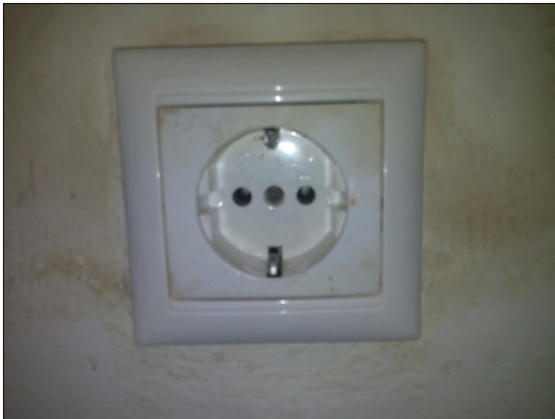
Εικόνα 7: Ρευματοδότης 'Schuko' για Φις Τύπου F και C
