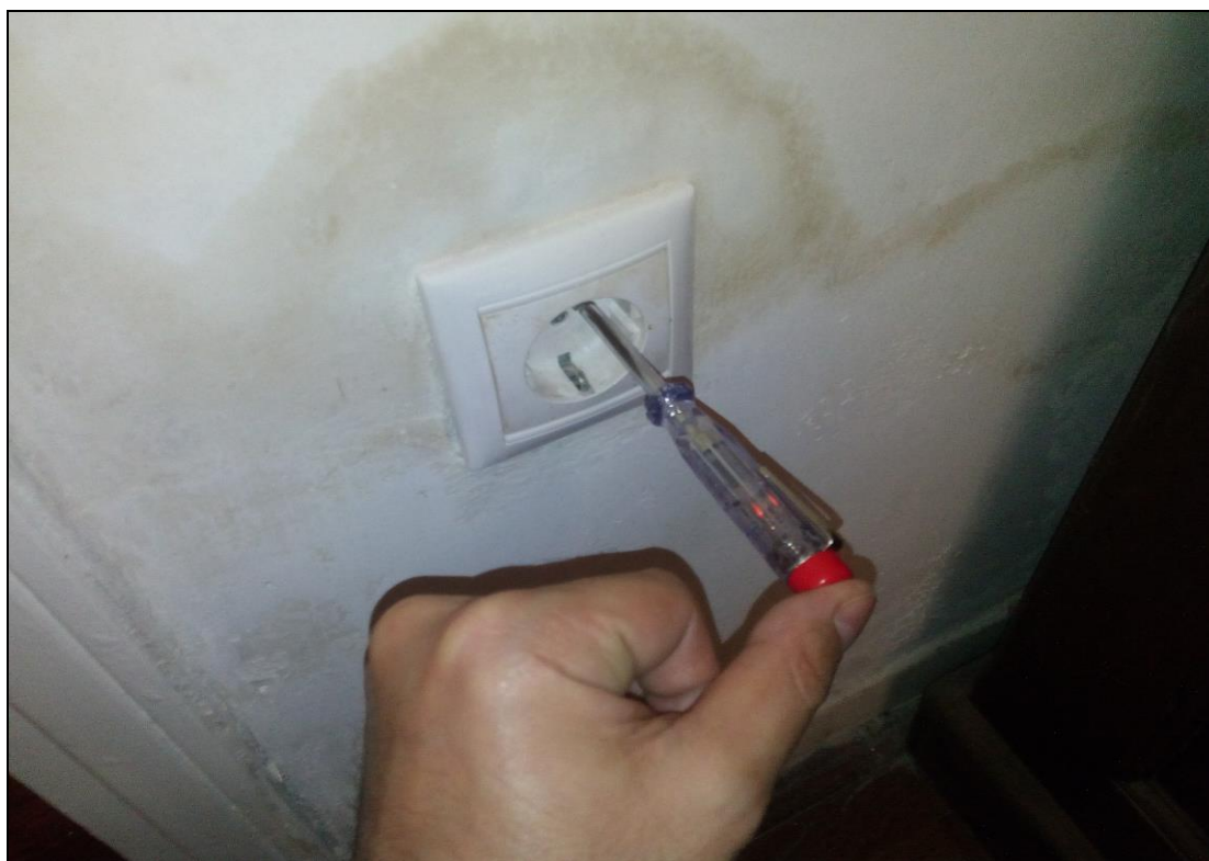
Βήμα 3 ο : Αποσυναρμολογούμε με το κατσαβίδι το περίβλημα του ρευματοδότη.
